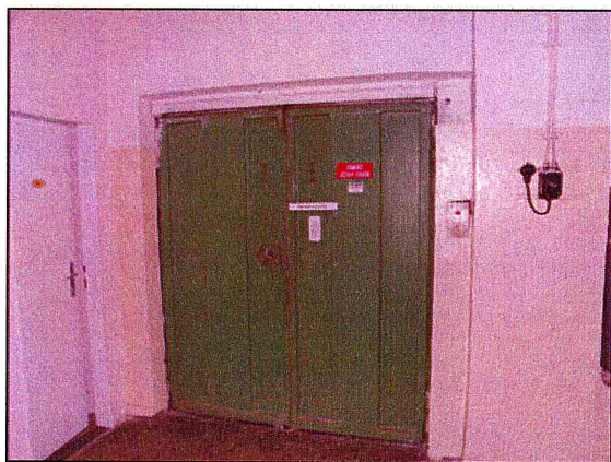
obr.2 – pohled na typické nástupiště výtahu
