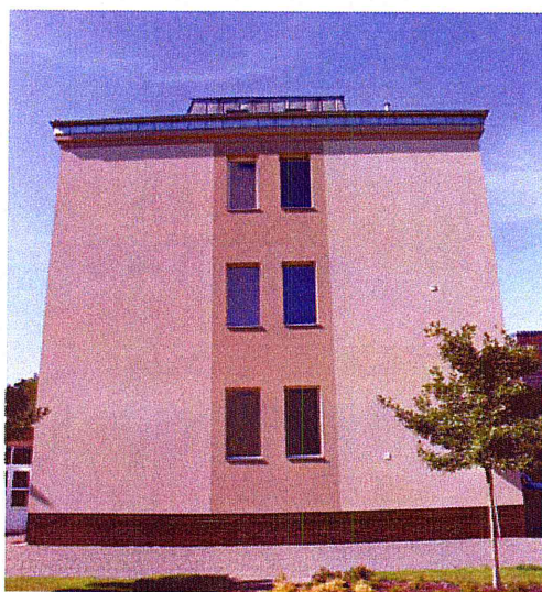
obr.1 – vnější pohled na budovu E3
