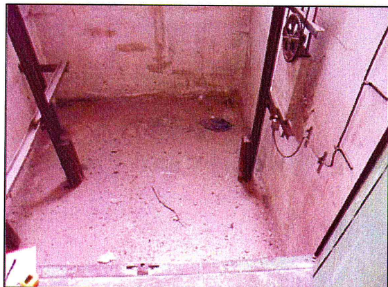
obr.6 – prohlubeň výtahové šachty
