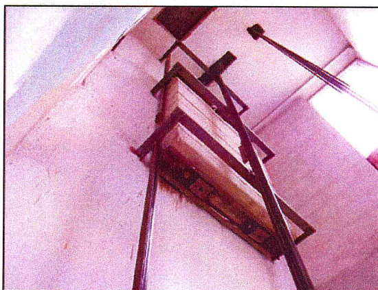
obr.5 – pohled na betonovou protiváhu výtahu
