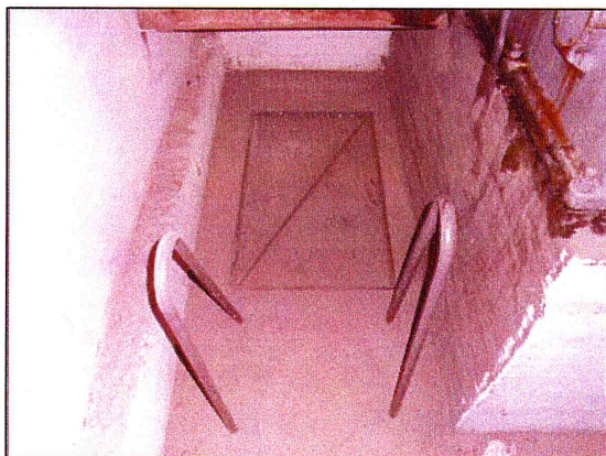
obr.10 – pohled na montážní poklop s nosníkem I 10
