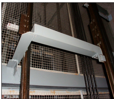
obr.8 – kotvení výtahu č.2
