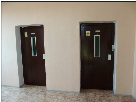
obr.2 – pohled na typické nástupiště výtahů
