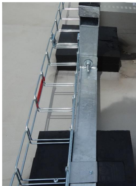
Příklad provedení kabelových žlabů pro AC i DC vedení
