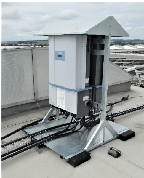
Příklad provedení a umístění střídače a DC rozvaděče
