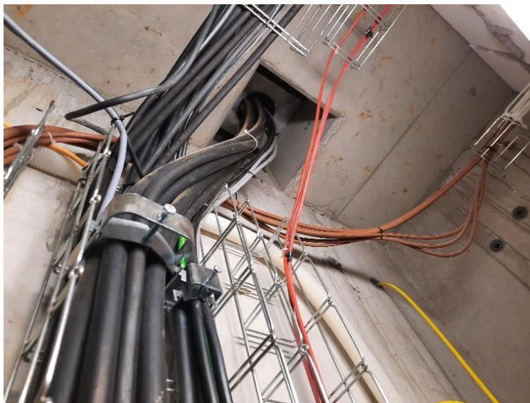
Místo prostu kabelové trasy z 4.NP a kabelová trasa do hlavního rozvaděče budovy
