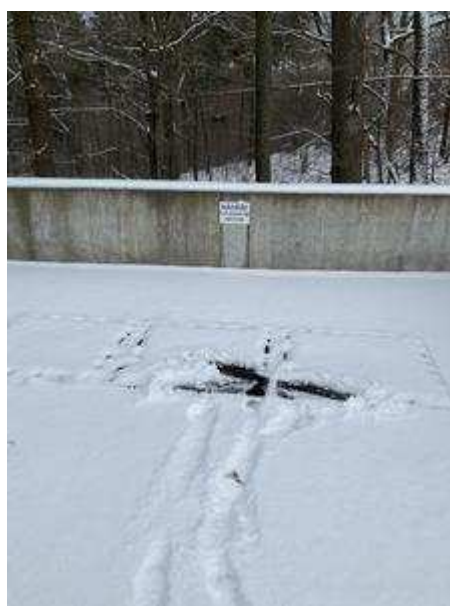
Obrázek 3 - podzemní nádrže PHM
