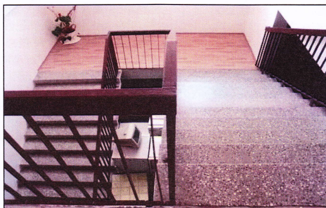
obr.5 – pohled na podestu
