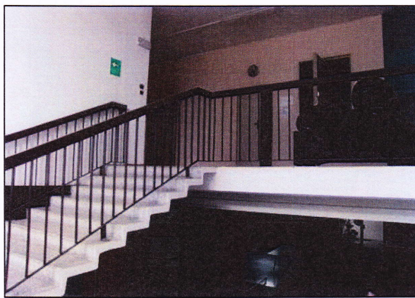
obr.4 – pohled na první podlaží
