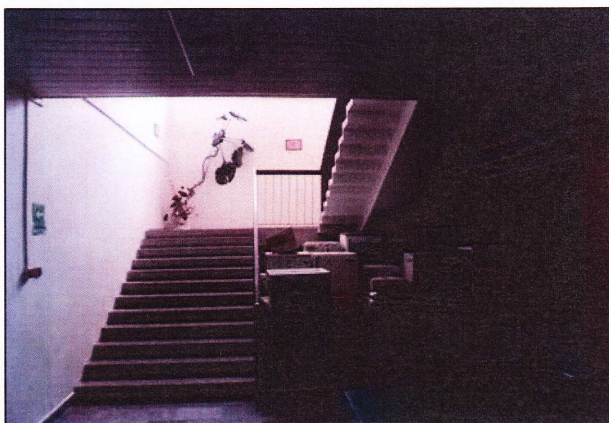
obr.3 – pohled na schodiště z přízemí
